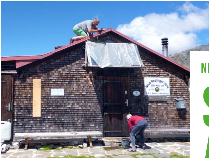
Firstbalken und Türen neu eingelassen
